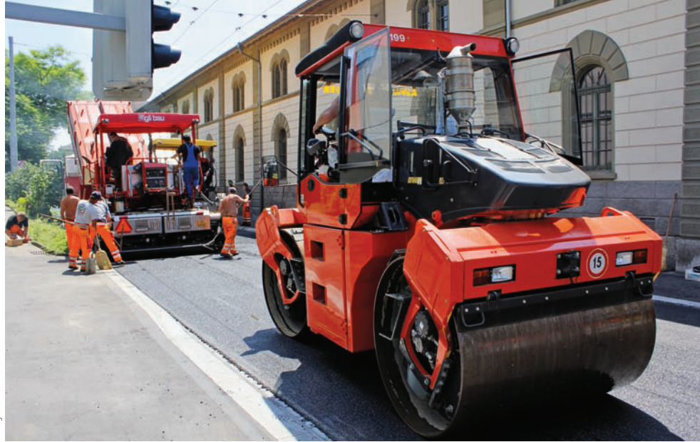
Mitarbeitende der Egli Bau im Einsatz.
