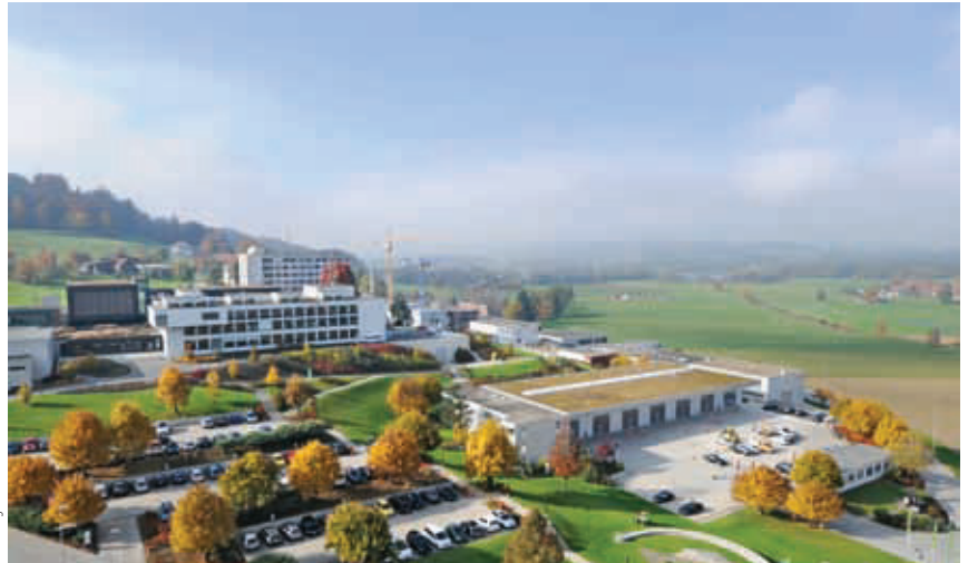
Das weitläufige Areal des Campus Sursee umfasst unter anderem acht Werkhallen, eine Maschinistenhalle sowie Übungsgelände für Baumaschinen- und Kranführer.
