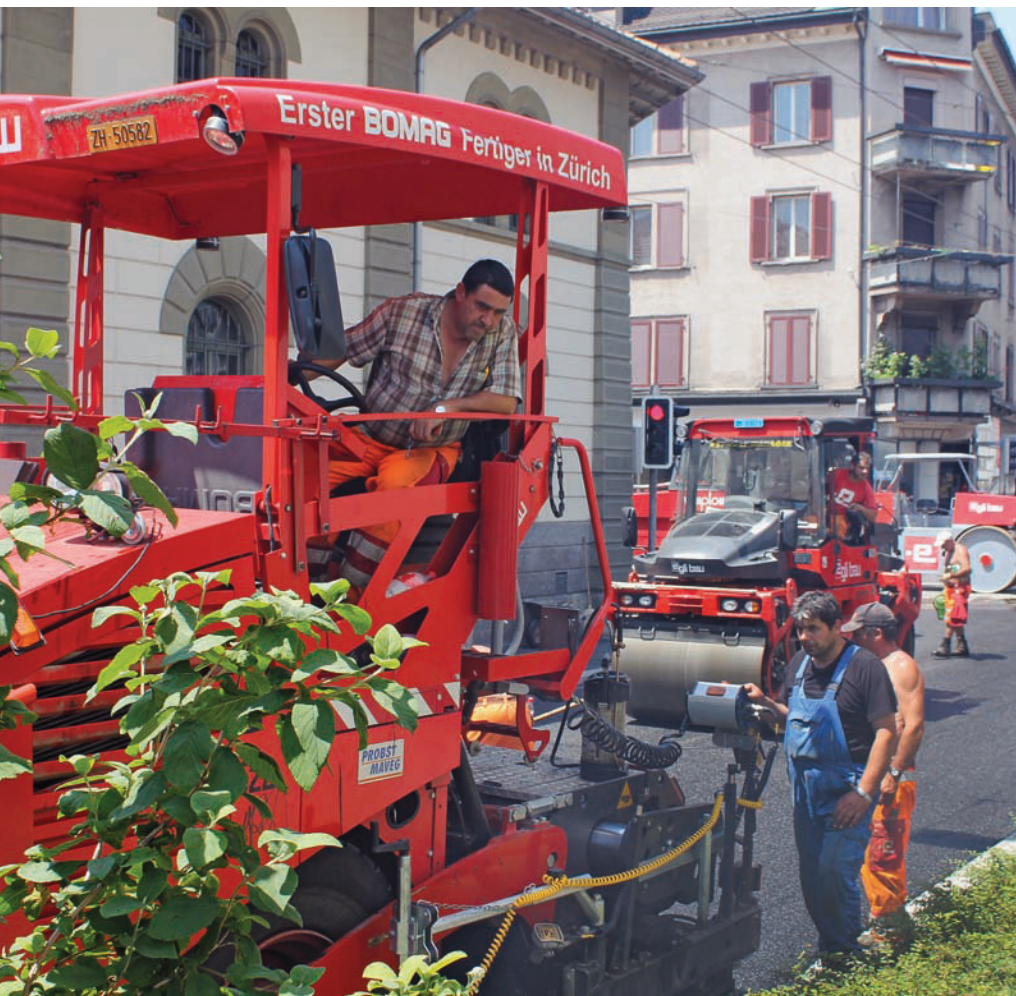
«La qualité de nos constructions se reflète dans le haut degré de satisfaction des maîtres d'ouvrage», explique le directeur d'Egli Bau SA.
