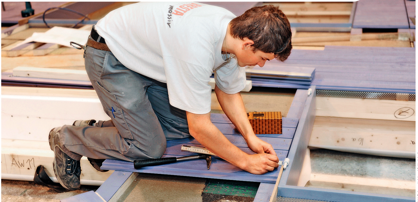
Bild: Tschopp Holzbau AG, Hirschdorf
